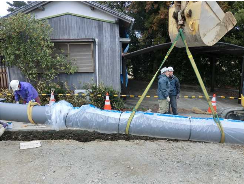
直管の吊り込み
