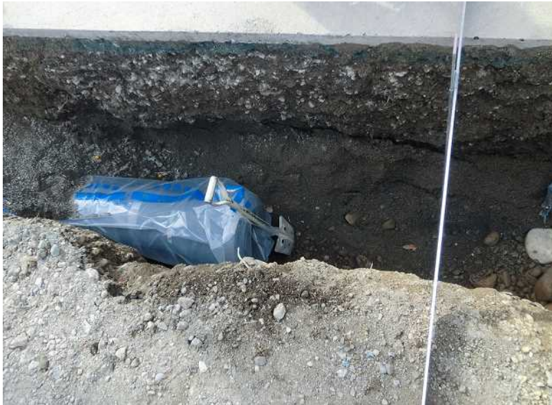
布設済配管 GX φ 300 ・ポリエチレンスリーブ で被覆
