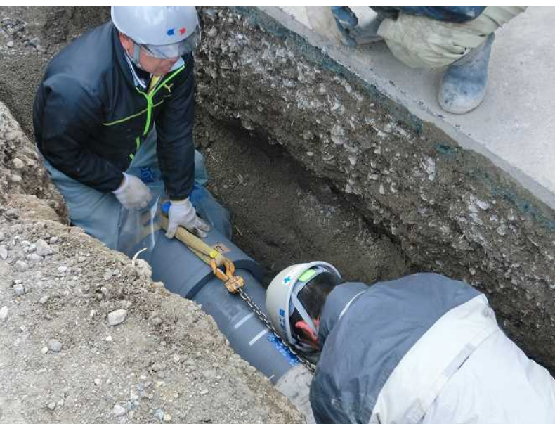
直管の接続作業
